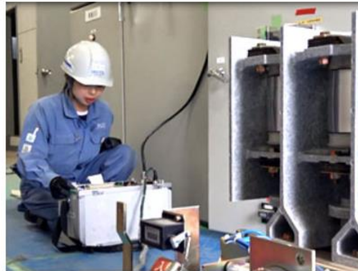
変電設備の動作試験
