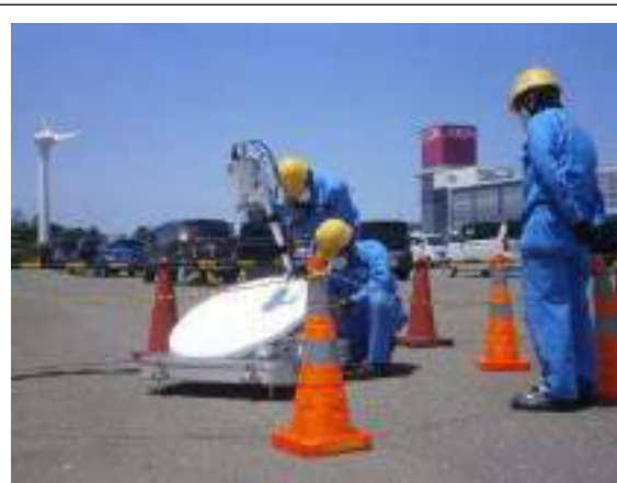
衛星回線を活用した通信回線設置
