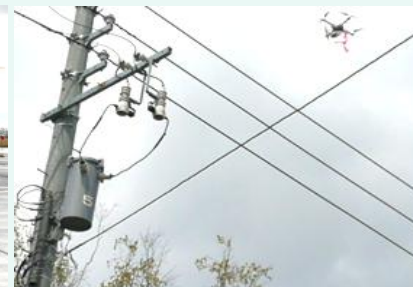
ドローンによる設備確認
