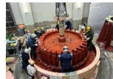
リプレース工事の様子
