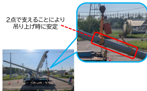
【建柱車による吊り上げ作業の効率化】
