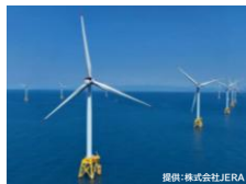
石狩湾新港の洋上風力発電 (2024年1月運開)
