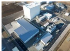
苫小牧市のバイオマス発電 (2026年2月運開)
