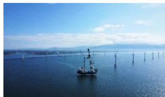
石狩湾の洋上風力発電 (2024年1月運開)
