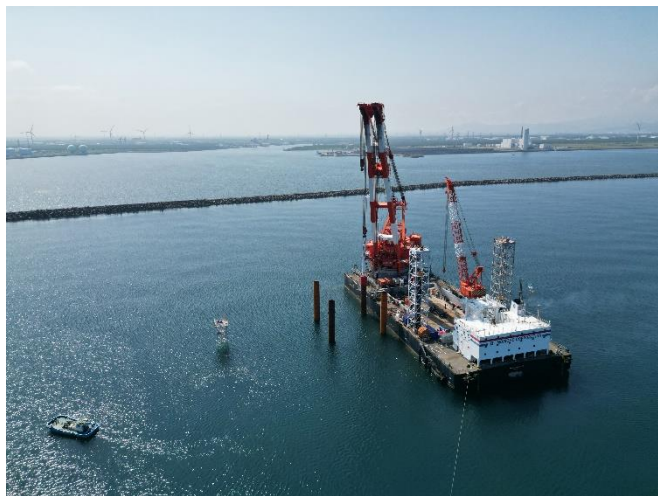
【建設工事の様子】
