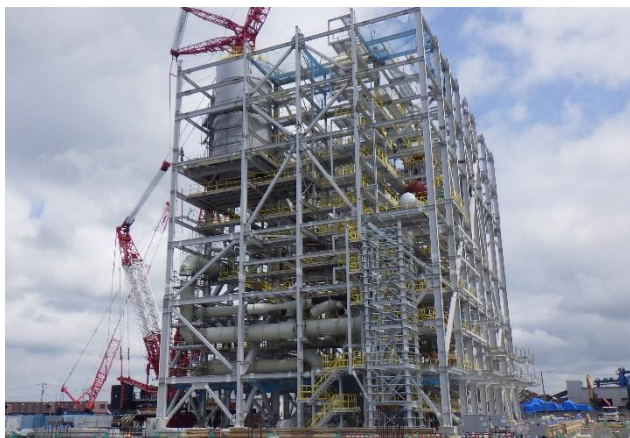
【建設工事の様子】
