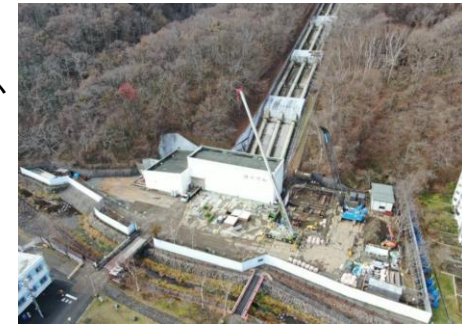
藻岩発電所リプレース工事の様子
