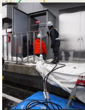
ケーブル接続作業
