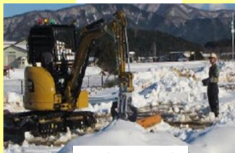
無線重機訓練
