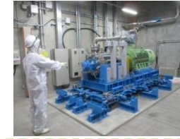
蒸気発生器直接給水用高圧ポンプ
