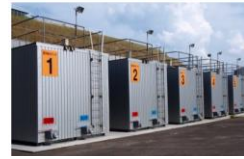
代替屋外給水タンク※
