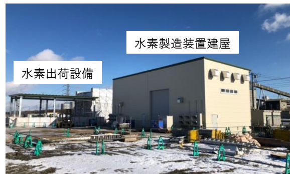
水素製造装置建屋 外観
