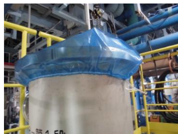
タンク、配管の両端の開口部をカバーでふさぐようす
