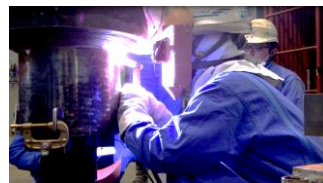
新施工法の様子
