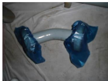
タンク、配管の両端の開口部をカバーでふさぐようす
