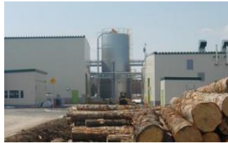
下川町木質バイオマス発電所
