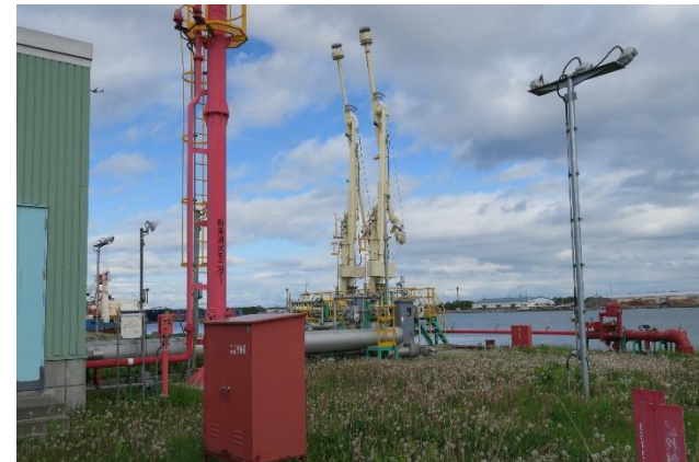
LNG内航船バース内のローディングアーム
