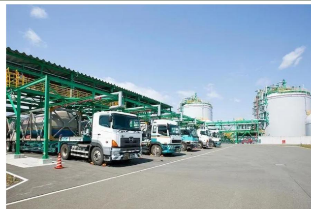
勇払LNGプラント LNGローリー出荷・受入設備とLNGタンク 出所: 石油資源開発株式会社
