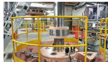
リプレイス工事後の水車室
