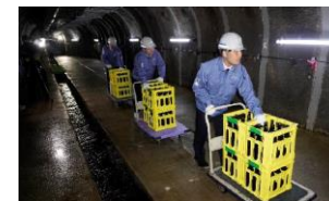
トンネル内への搬入の様子
