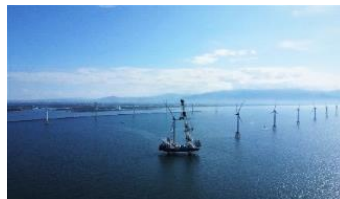
石狩湾の洋上風力発電 (2024年1月運開)
