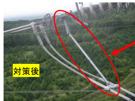
電線の振れ止め対策
