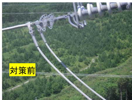
電線の振れ止め対策
