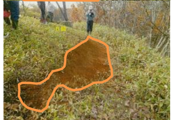
地割れ・間隙等の補修（土砂充填）
