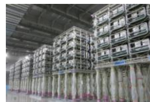
北斗変換所の変換器
