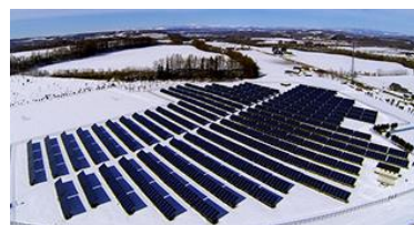
本別太陽の丘ソーラー発電所
