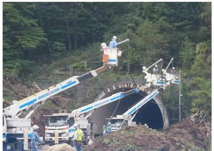
土砂崩れにより電柱が流失した現場において、新たに電線を張っている様子（厚真町）【9/13撮影】
