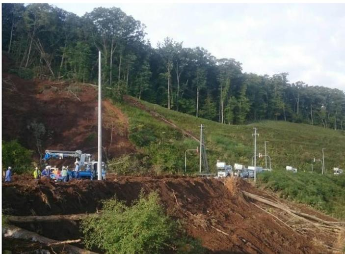
土砂崩れにより電柱が流失した現場において、新たに電柱を建てている様子（厚真町）【9/13撮影】
