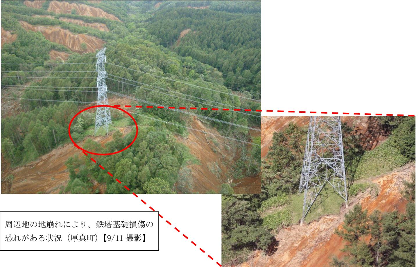
周辺地の地崩れにより、鉄塔基礎損傷の恐れがある状況（厚真町）【9/11撮影】
