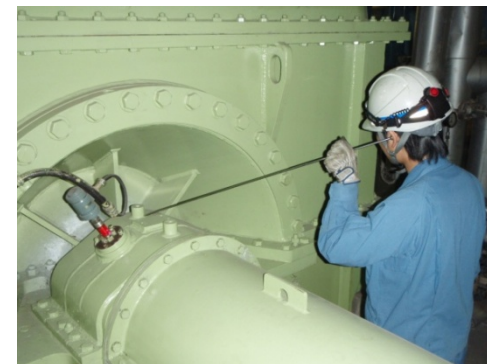
現場でのパトロール状況
