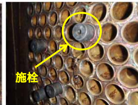
【写真】施栓状況
