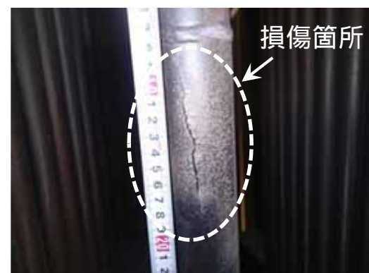
【写真】 再熱器管損傷状況
