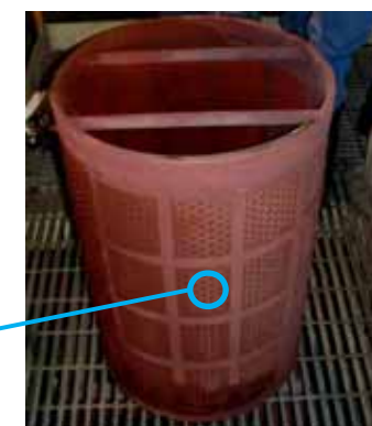
給水ポンプ ストレーナ
