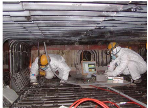
過熱器深層部の超音波肉厚測定装置による測定状況
