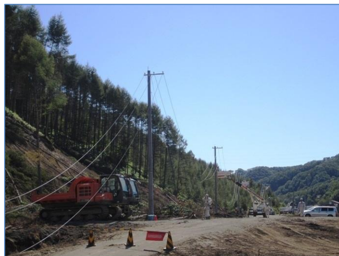
道路が復旧した箇所から順次復旧作業を進める（厚真町）
