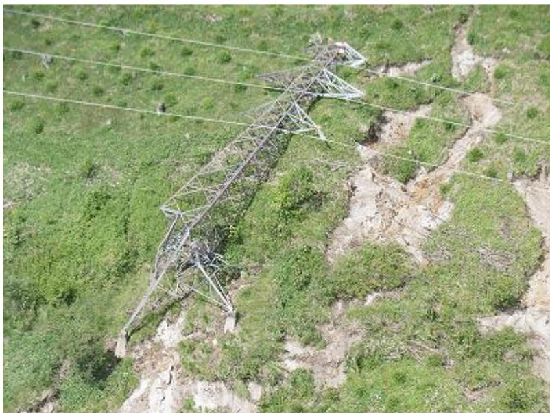
地崩れにより倒壊した送電鉄塔（むかわ町）
