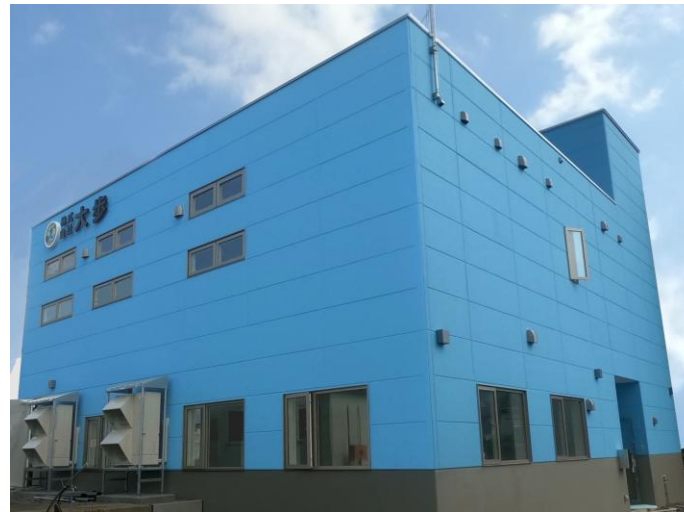
（写真）大歩社屋外観
