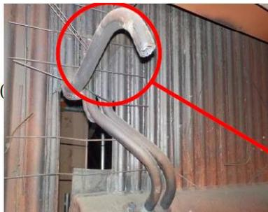
ボイラーの損傷(苫東2号機)
