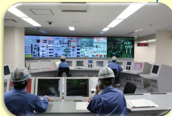
運転訓練用シミュレータの改造を検討 (H30年度竣工予定)
