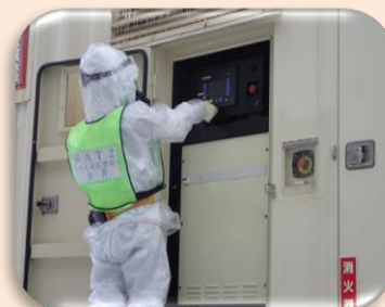
電源車起動訓練
