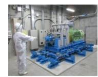
▲ 蒸気発生器直接給水用高圧ポンプ
