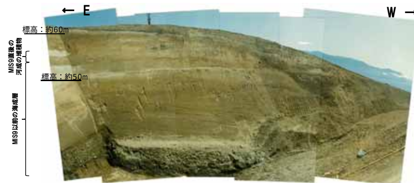
写真2 南側壁面を望む(昭和57年秋頃撮影)
