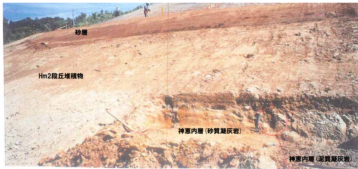
全景写真 (敷地造成工事時確認箇所)
