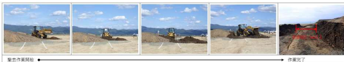
第 15 図 土砂撤去状況写真
