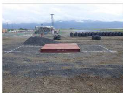
検証ヤード（復旧前）
