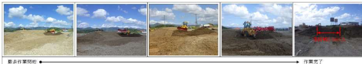
第5図 土砂撤去状況写真
