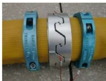
可搬型ホース(150A)接続後
