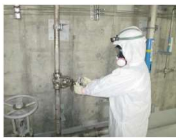
可搬型大型送水ポンプ車による原子炉格納容器内へのスプレイ系統構成 （運転員（現場）C） （原子炉補助建屋 T. P. 10. 3m） （作業風景は類似作業）
