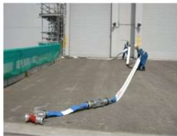
可搬型ホース敷設 （屋外）
