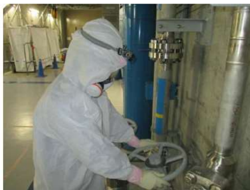
原子炉容器から原子炉格納容器への切替え 系統構成 （原子炉補助建屋 T. P. 10. 3m） （作業風景は類似作業）
