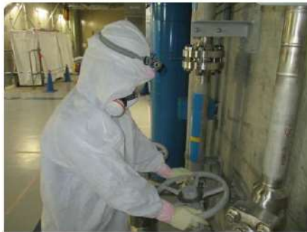
格納容器スプレイから炉心注水への切り替え 系統構成 (原子炉補助建屋 T.P. 10.3m) (作業風景は類似作業)
