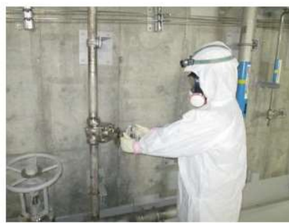
可搬型大型送水ポンプ車による原子炉 格納容器下部への注水系統構成 （運転員（現場）C） （原子炉補助建屋 T. P. 10. 3m） （作業風景は類似作業）
