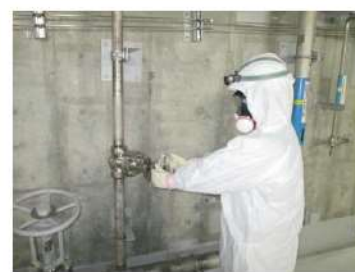
可搬型大型送水ポンプ車による 原子炉容器への注水 系統構成 (運転員 (現場) C) (原子炉補助建屋 T.P. 10.3m) (作業風景は類似作業)
