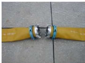
可搬型ホース（150A）接続前
