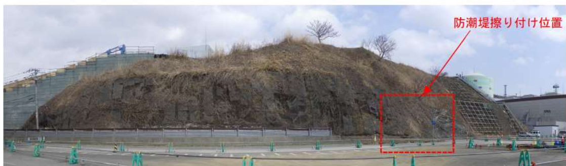
T. P. 10m の敷地高から撮影した端部岩盤（全景 1 の黄破線枠）（図 2. 1. a. c-4(1)再掲）
