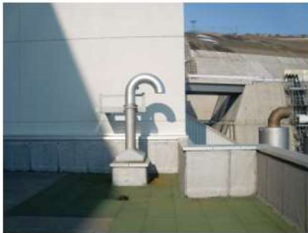
第 1 図 タービン動補助給水ポンプ排気管の設置状況
