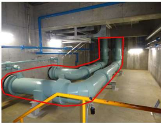
原子炉補機冷却海水排水配管 (電機建屋敷設状況)
