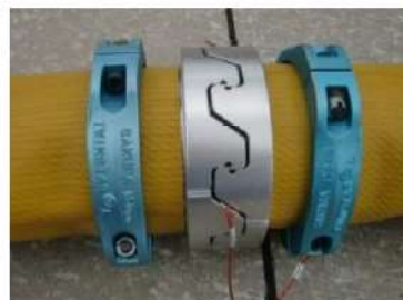
可搬型ホース(150A)接続後
