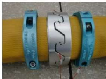
可搬型ホース (150A) 接続後
