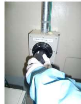
電源ケーブル接続
