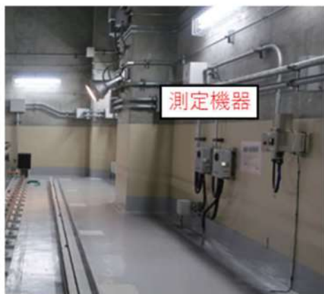
⑦使用済燃料ピット周り
