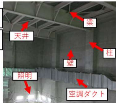
②使用済燃料ピット上部
