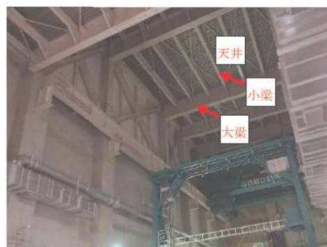
図 5.2.2 燃料取扱棟の屋根
