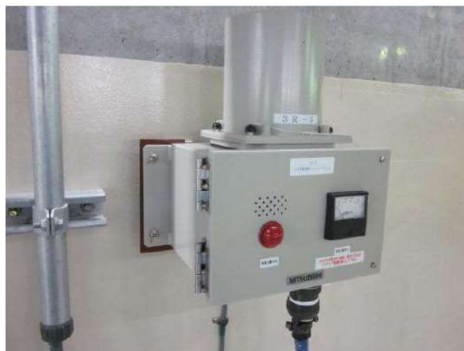
図2 機器のボルトによる壁面固定
