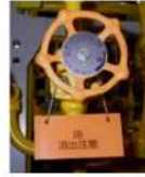
油類に係る弁 弁の識別
