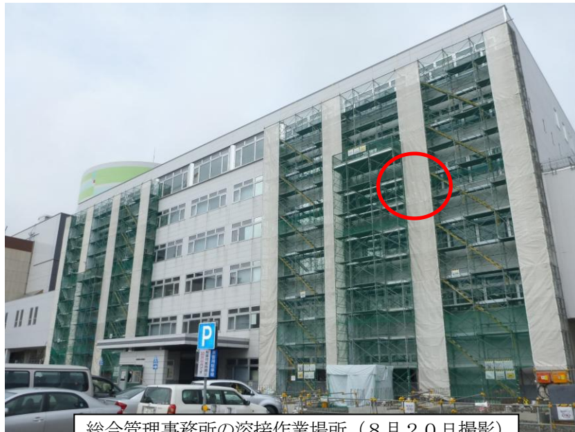
総合管理事務所の溶接作業場所（8月20日撮影）
