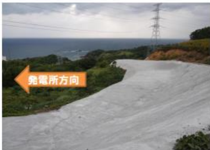
幅20m～46mに植生防止のため モルタル吹き付け
