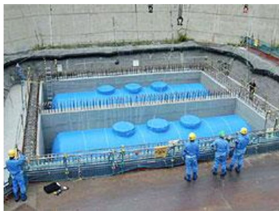
ディーゼル発電機燃料油貯油槽 設置工事時の状況(追加設置)
