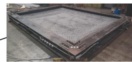
飛来物防護設備(新設の例)
