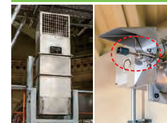
静的触媒式水素再結合装置
