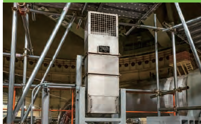
静的触媒式水素再結合装置
