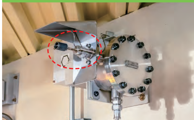
イグナイタ(電気式水素燃焼装置)
