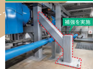
耐震補強工事の例
