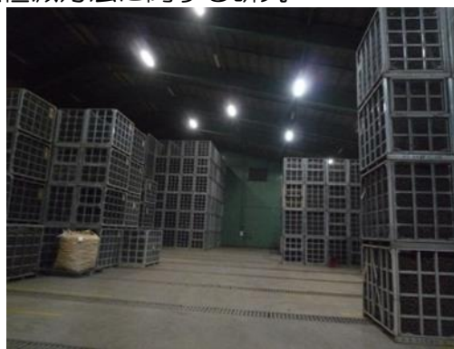
ポテライトが明るい環境下でも緑化を抑制することから、搬出入の作業性や安全性が向上したジャガイモ保管庫
