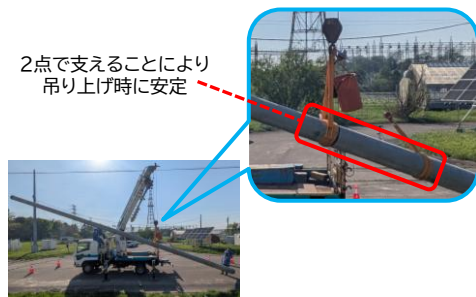
【建柱車による吊り上げ作業の効率化】
