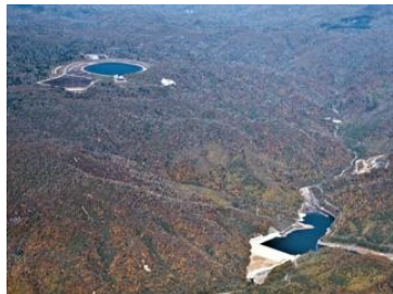
京極発電所(純揚水)
