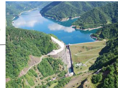
新冠発電所(混合揚水)
