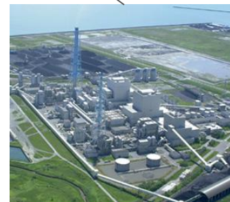
苫東厚真発電所(石炭火力)
