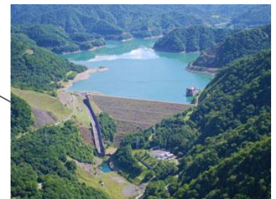
高見発電所(混合揚水)
