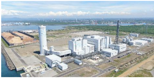
石狩湾新港発電所(LNG火力)
