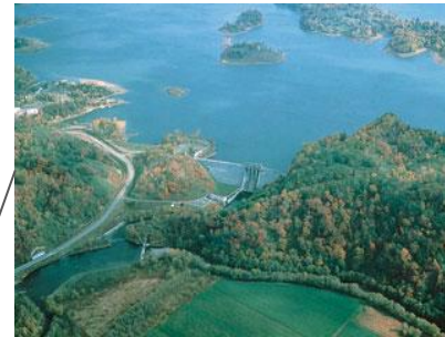
雨竜発電所(水力)
