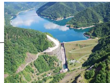
新冠発電所(混合揚水)
