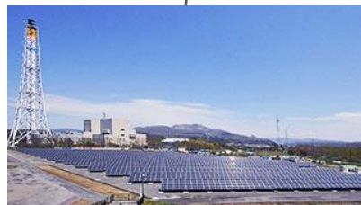
伊達ソーラー発電所(太陽光)
