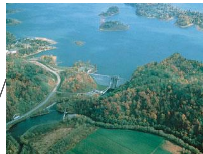
雨竜発電所(水力)
