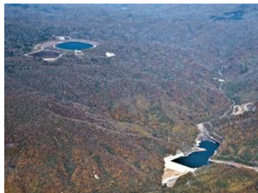
京極発電所(純揚水)
