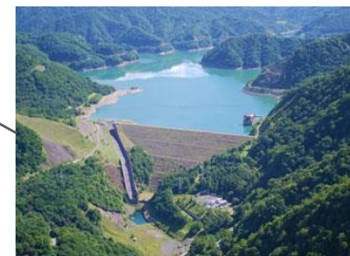
高見発電所(混合揚水)
