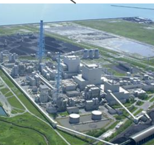
苫東厚真発電所(石炭火力)
