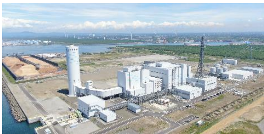
石狩湾新港発電所(LNG火力)
