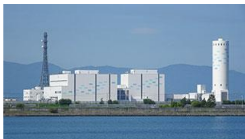
石狩湾新港発電所
