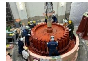
リプレース工事の様子
