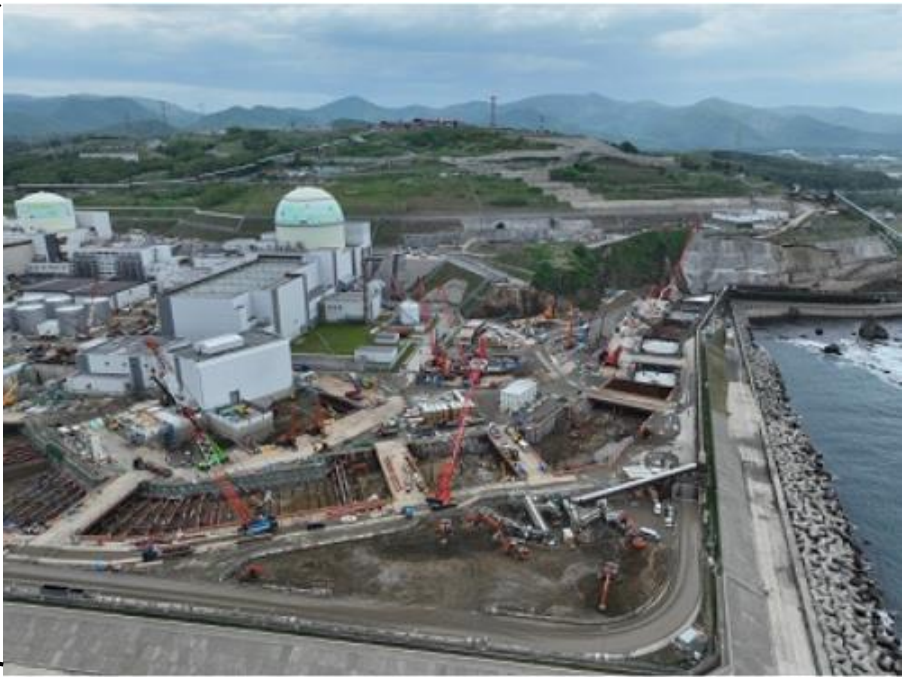
工事の状況 (2025年6月撮影)
