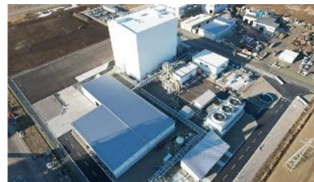
苫小牧市のバイオマス発電所 (2025年5月運開予定)
