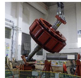
リプレース工事の様子
