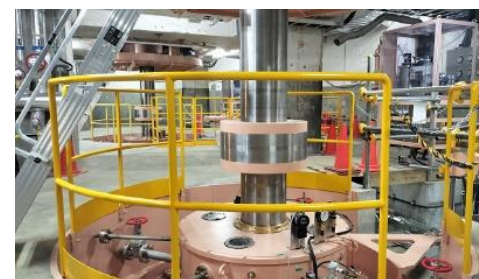
リプレース工事後の水車室
