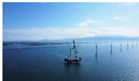
石狩湾の洋上風力発電 (2024年1月運開)
