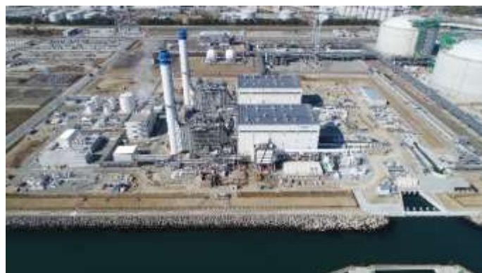
1号機運転中（奥側） 2号機試運転中（手前側）
