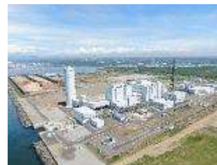
石狩湾新港発電所
