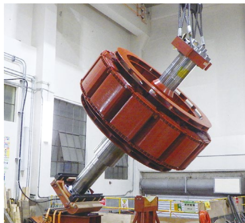
発電機ローターの更新
