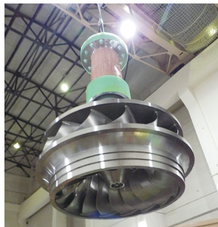
水車ランナの据付
