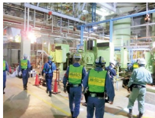
当社と請負工事会社合同の現場安全パトロール
