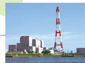
苫小牧発電所 (重原油・天然ガス) 1号機 250,000kW (1973年11月運転開始)
