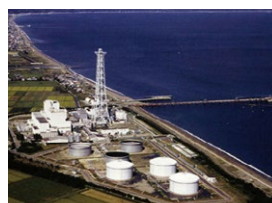
知内発電所 (重油) 1号機 350,000kW (1983年12月運転開始) 2号機 350,000kW (1998年9月運転開始)
