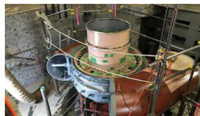
層雲峡発電所のケーシング更新作業の様子
