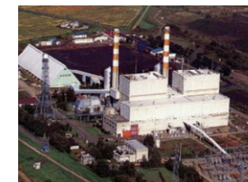
奈井江発電所 (国内炭) 1号機 175,000kW (1968年5月運転開始) 2号機 175,000kW (1970年2月運転開始) ※2019年3月休止 2027年3月廃止予定
