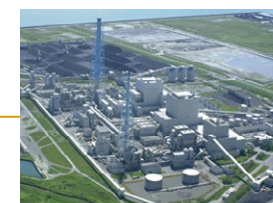
苫東厚真発電所 (海外炭) 1号機 350,000kW (1980年10月運転開始) 2号機 600,000kW (1985年10月運転開始) 4号機 700,000kW (2002年6月運転開始)
