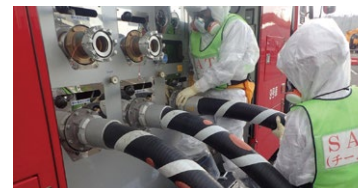
燃料を冷やし続けるための代替給水訓練
