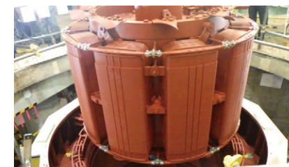
層雲峡発電所の発電機更新作業の様子
