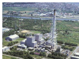
伊達発電所 (重油) 1号機 350,000kW (1978年11月運転開始) 2号機 350,000kW (1980年3月運転開始)
