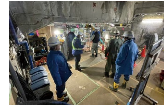
当社と請負工事会社合同現場安全パトロール
