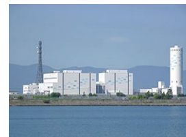
石狩湾新港発電所 (LNG) 1号機 569,400kW (2019年2月運転開始)
