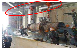
発電停止後直ちに点検を行うための「外段取り化」の例
