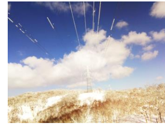
着雪監視状況
