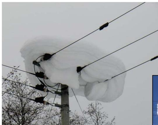
停電の未然防止を図るため冠雪除去作業に多大な労力を要しています。
