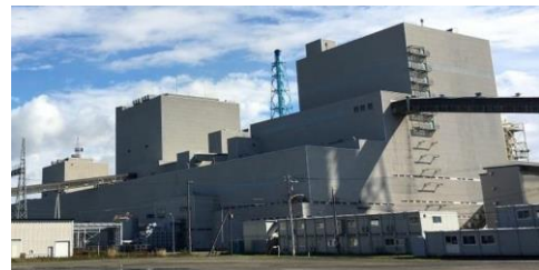
苫東厚真発電所
